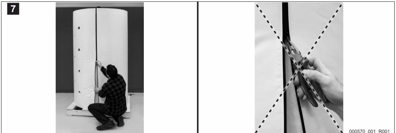
3. Schieben Sie den Reißverschluss vollständig nach unten [7].
