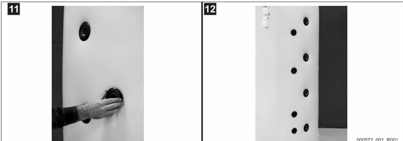
6. Drehen Sie die Rosette mit einem leichten Druck im Uhrzeigersinn auf den Rohranschluss [11], [12].
