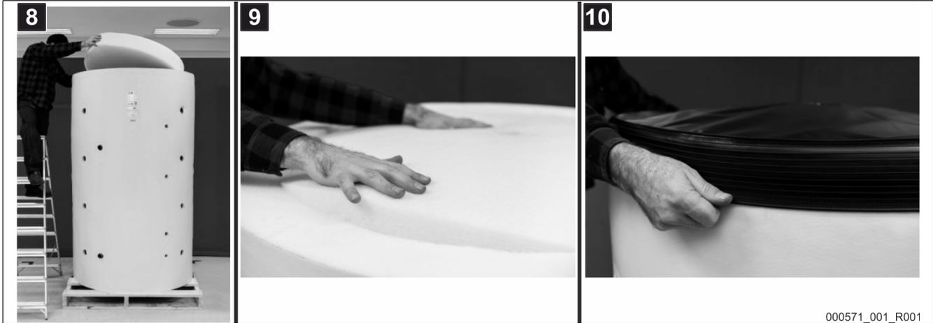
4. Setzen Sie die obere Wärmedämmscheibe auf [8], [9].
