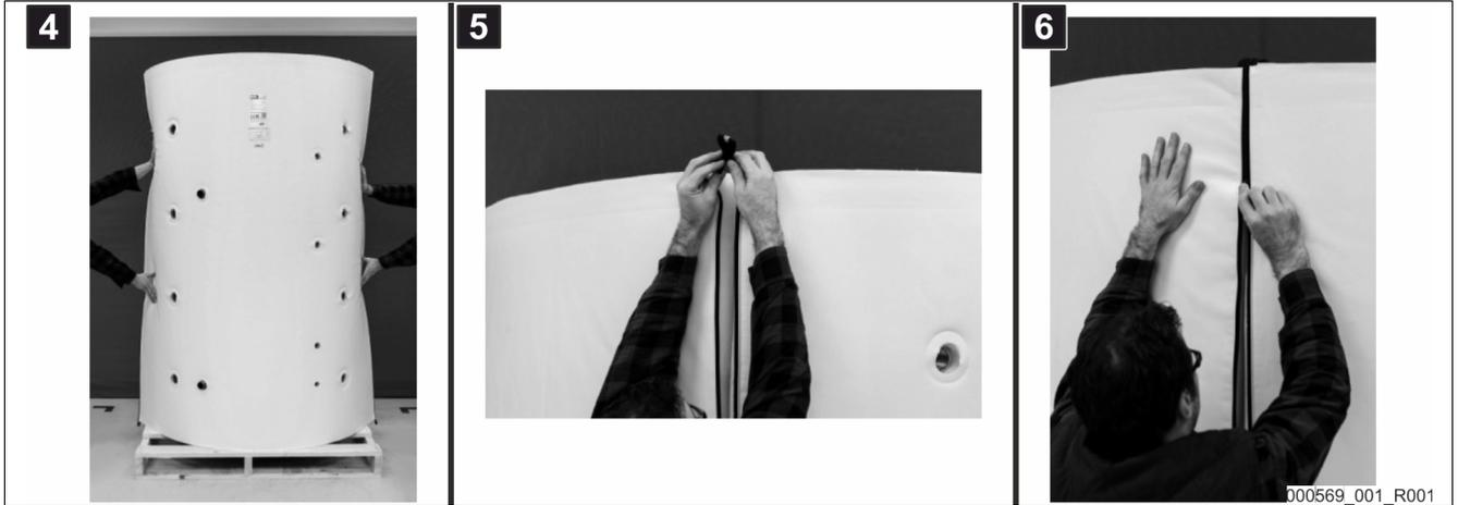
1. Verteilen Sie die Wärmedämmung gleichmäßig über den gesamten Umfang des Behälters [4].
